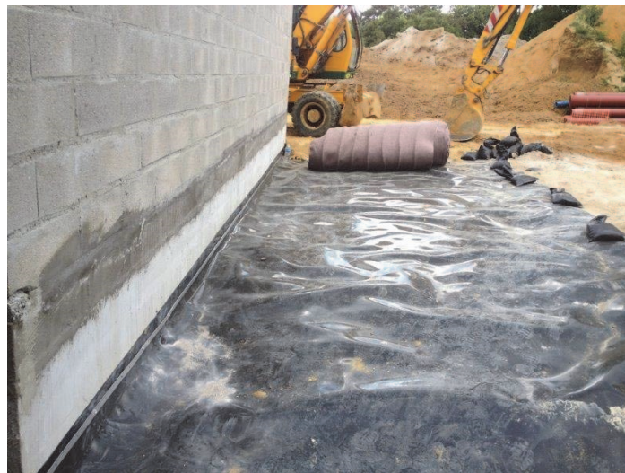
Figure 4. Raccordement Géomembrane/Maçonnerie
