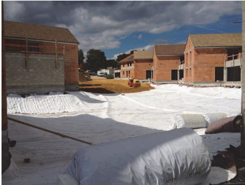
Figure 6. Pose du géocomposite de drainage entre les villas
