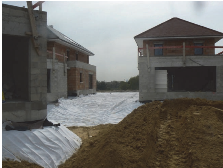
Figure 8. Vue du bassin de rétention
